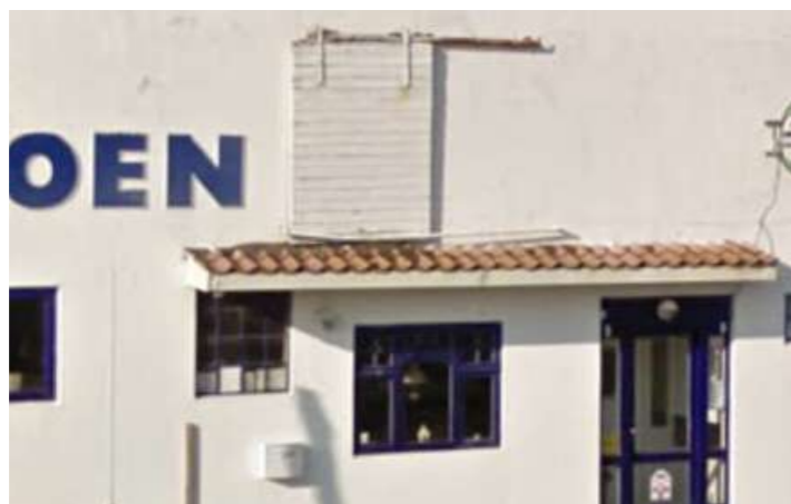
Eksisterende hvidpudset ydermur
